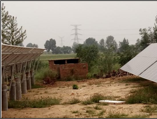
施工现场设置旱厕
