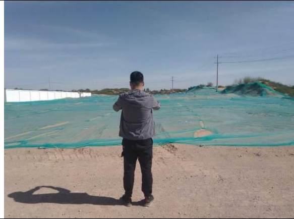
裸露地表苫盖
