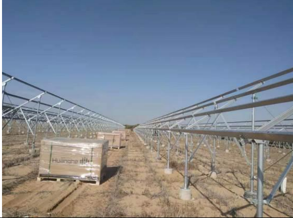
混凝土管桩支架采用打桩机打入
