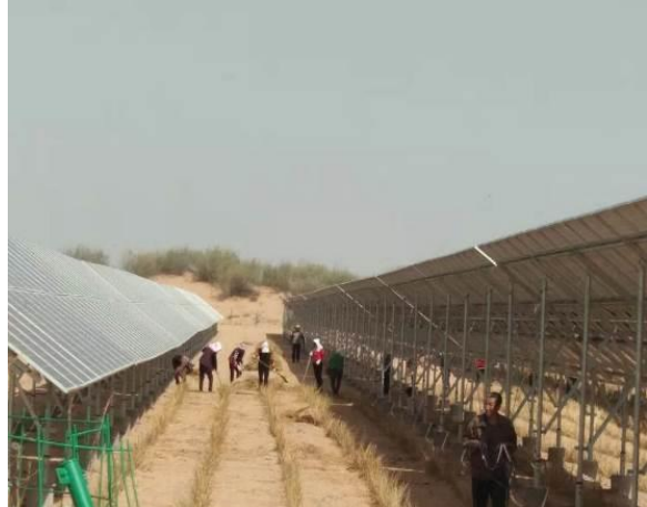
光伏阵列区防风固沙及生态恢复施工
