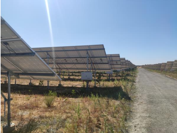
3号发电区内碎石铺垫的道路
