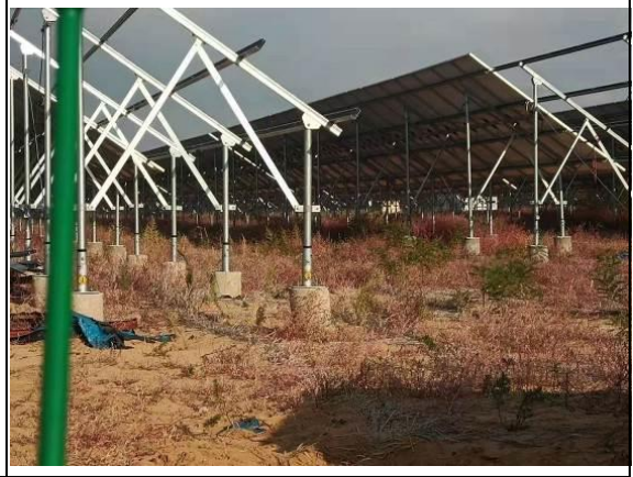
混凝土管桩支架采用打桩机打入
