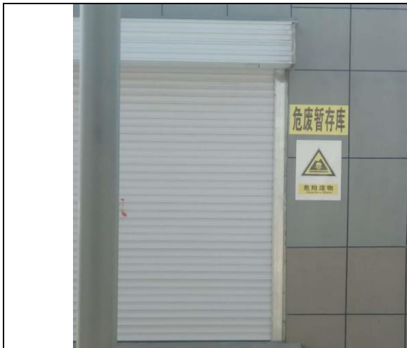
危废暂存库外部
