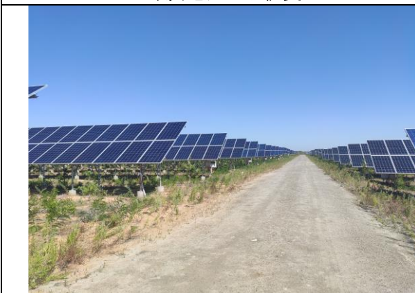
2号发电区内碎石铺垫的道路
