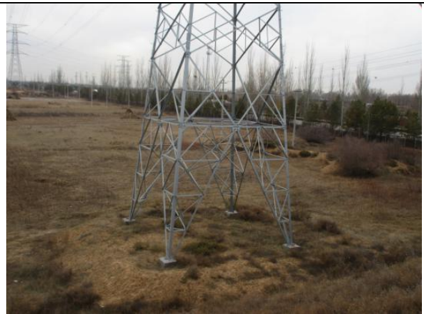
塔基附近植被恢复情况2
