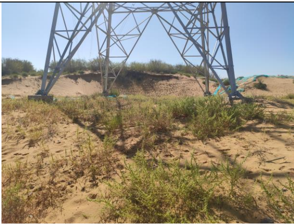
塔基附近植被恢复情况1
